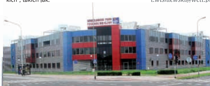
Wrocławski Park Technologiczny
